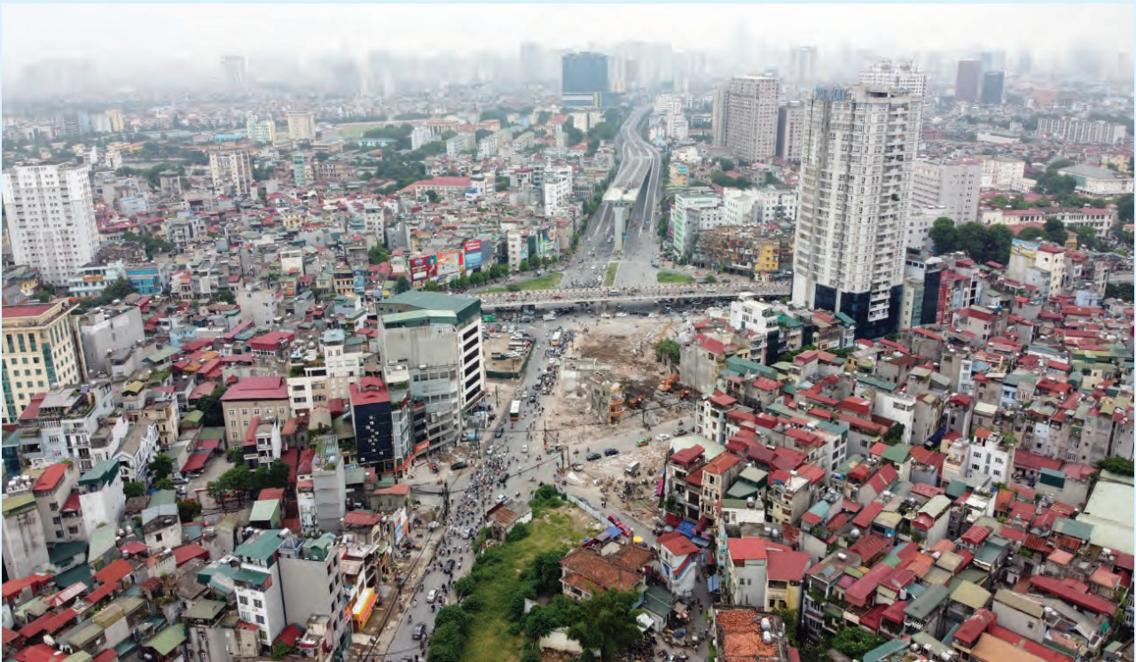
Ảnh minh họa phá dỡ công trình cũ trên đoạn đường Đại La - Hà Nội, tháng 8/2020. Nguồn: Đại học Xây dựng
