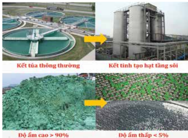
▲ Hình 3. So sánh công nghệ kết tinh và công nghệ tạo hạt tăng sôi (Nguồn: Viện Tài nguyên và Môi trường, 2022)
