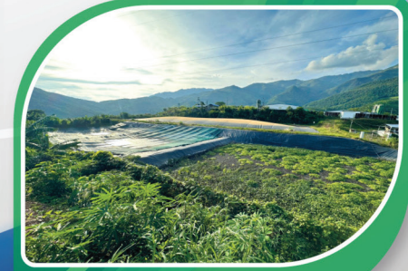
Bể điều hòa
