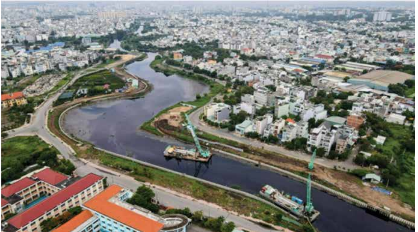
▲ Toàn bộ dự án cải tạo kênh Tham Lương - Bến Cát - rạch Nước Lên góp phần chỉnh trang đô thị và cải thiện môi trường cho TP Hồ Chí Minh
