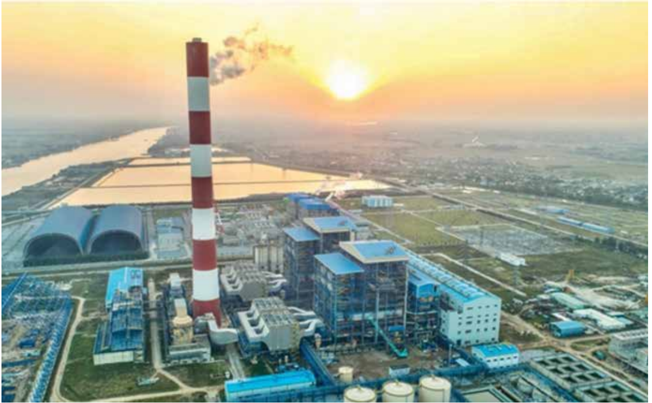
▲ Các nhà máy nhiệt điện xây dựng lộ trình chuyển đổi nhiên liệu để giảm phát thải KNK
